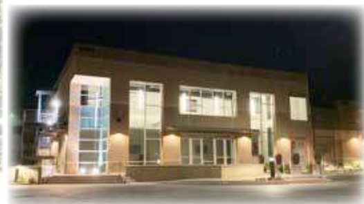
A 棟樓夜景。
